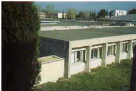
Toiture – terrasse Source CERTU
